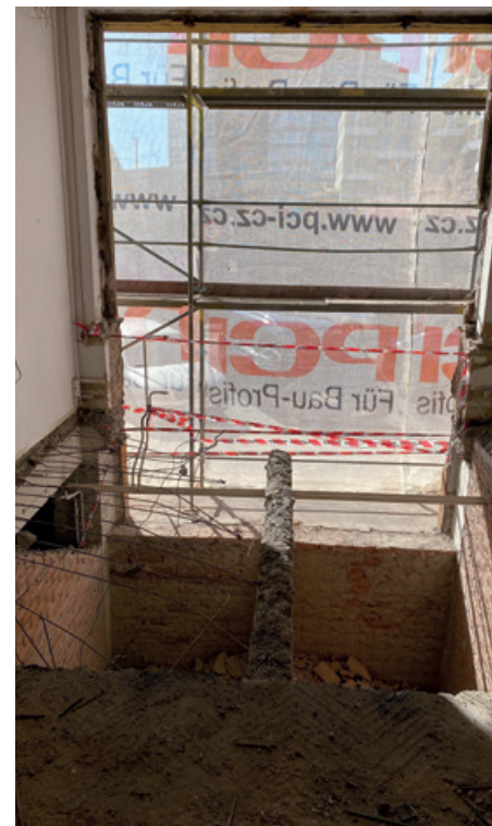
8. 4. 2020 Nový vchod do přízemí
